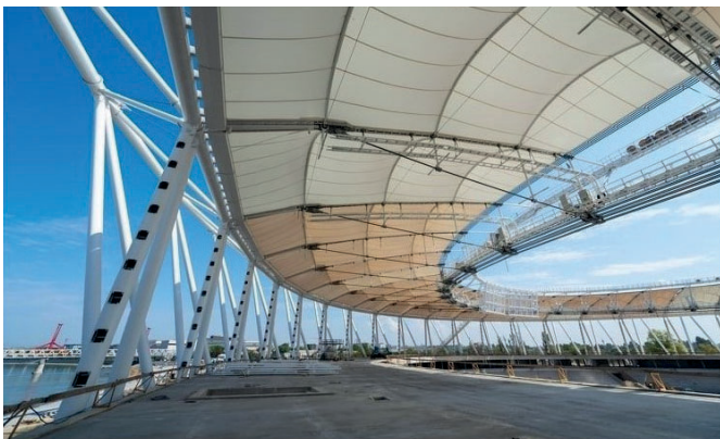
4. ábra. A membránnal kialakított tetőfedés részlete két nézetből
